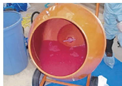
コンクリートミキサーで処理をする様子
